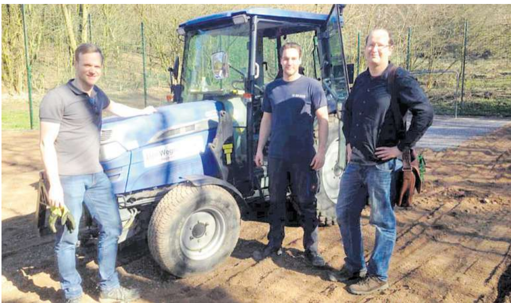
Anfang April startete die Sanierung des Bolzplatzes an der Richardstraße. Im Mai wird der Platz offiziell seiner Bestimmung übergeben. Foto: W. J. Ackermann
