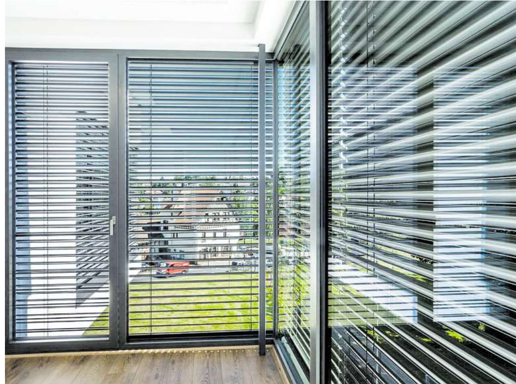
Außenliegende Raffstores schaffen kühle Temperaturen.
