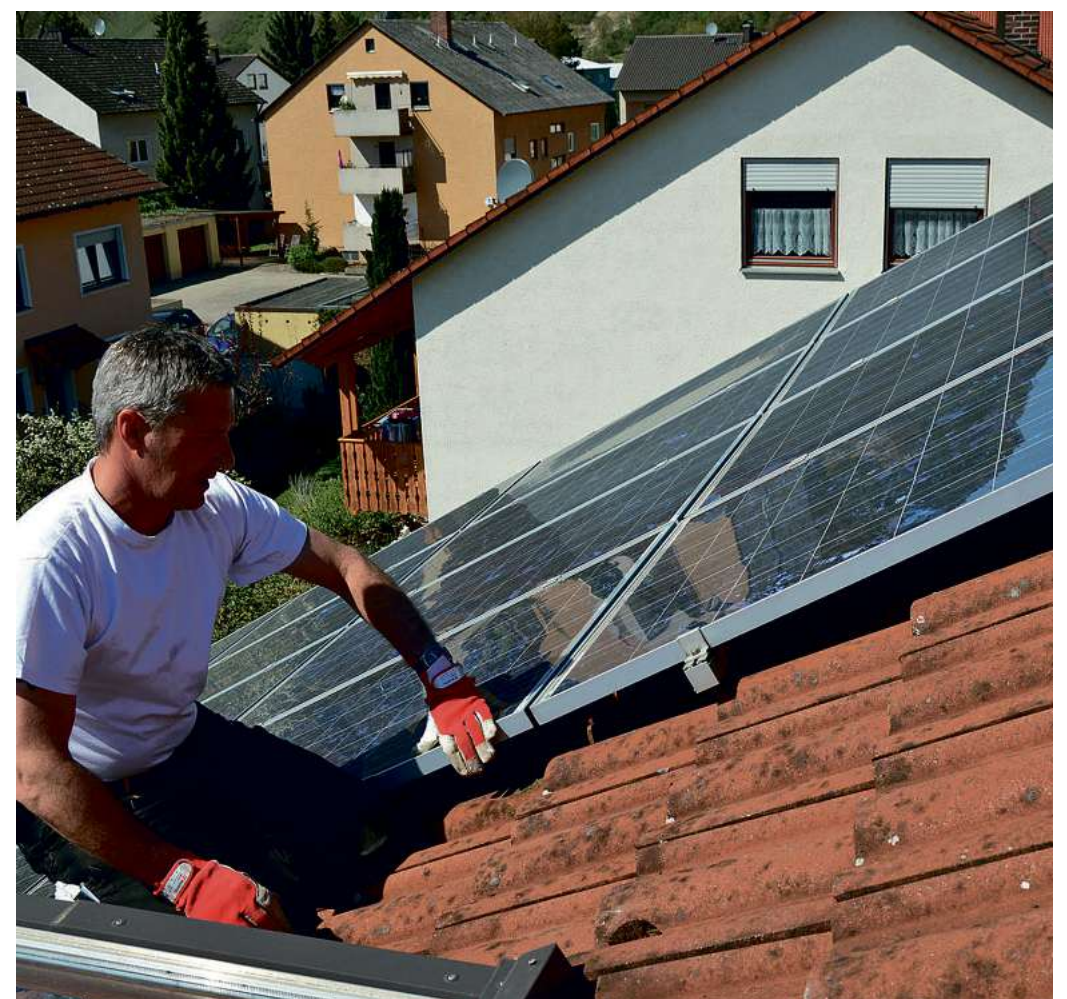
Ein Dach-Check sollte jedes Jahr vorgenommen werden.
