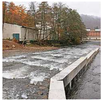
So sieht der neue Fischaufstieg aus. Foto: Wupperverband
