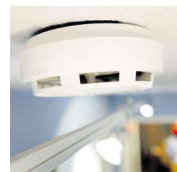
Rauchmelder werden an der Decke befestigt. Foto: Martin Gerten
