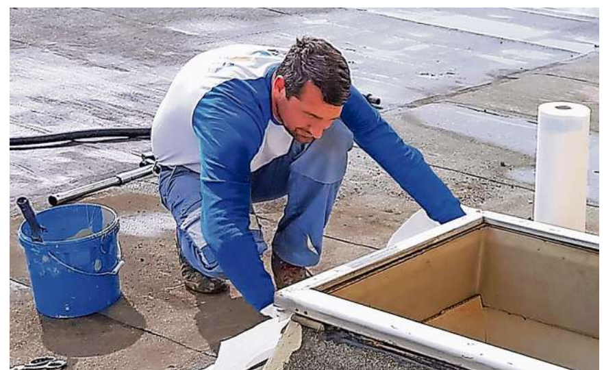
Der Fachmann weiß, wie auch ein Flachdach wirkungsvoll abgedichtet ist. Foto: Triflex
