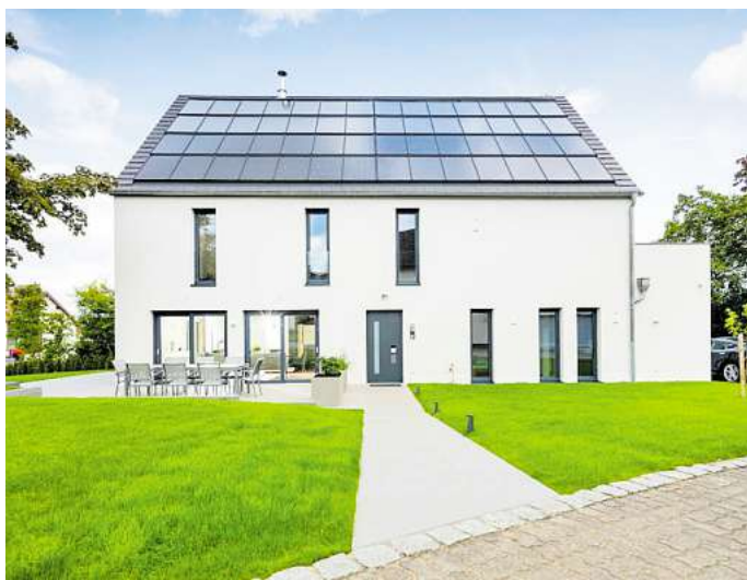
Die großen Photovoltaik- und Solarthermieanlagen auf diesem Plusenergiehaus erzeugen viel Energie für Wärme, Strom und Elektromobilität – mehr als der Haushalt selbst verbrauchen könnte. Foto: Udo Geisler
