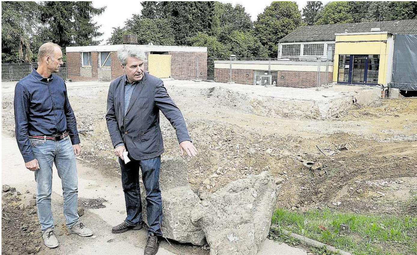
Projektleiter Hans-Josef Obladen (l.) und Martin Wagner, Sachgebietsleiter beim Gebäudemanagement der Stadt, sind optimistisch, den Neubau an der Grundschule Westersburg im Zeitplan zu bewältigen. Der Abriss des alten Gebäudes ist bereits erfolgt. Foto: Christian Beier
